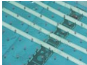
Floor heating – edge area
